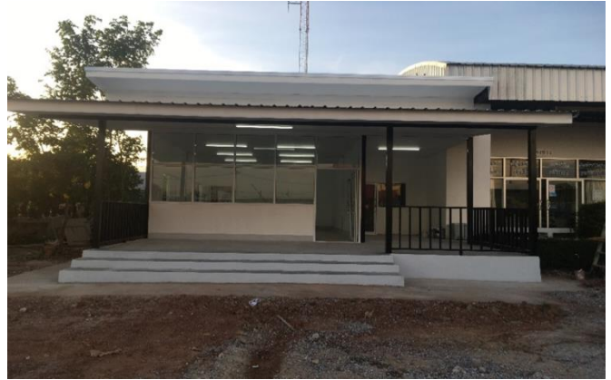
42.โครงการก่อสร้างอาคารกองการประปา
