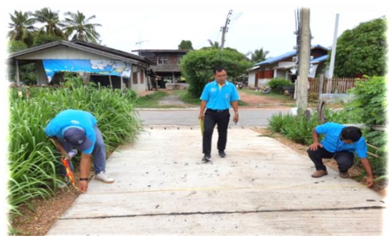
31. โครงการก่อสร้าง ถนน คสล. ซอย ประคองศิลป์
