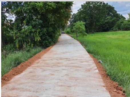
28. โครงการก่อสร้าง ถนน คสล. ซอย ถนนกลาง
