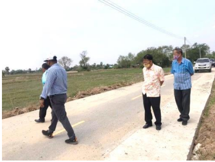
30. โครงการขยายผิวจราจร คสล. ถนน เทศบาล 5
