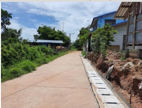
34. โครงการก่อสร้างรางระบายน้ำรูปตัวยู ซอย รุ่งรัตน์
