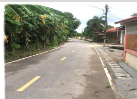
35. โครงการก่อสร้างรางระบายน้ำรูปตัวยู ซอยเทศบาล 1
