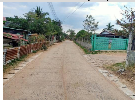
37. โครงการก่อสร้างรางระบายน้ำรูปตัวยู ซ.ไสว
